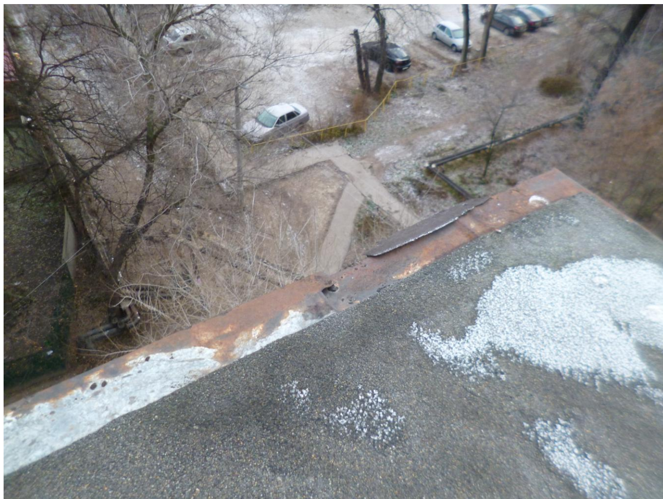
Фото 5. Разрушение карнизных металлических отливов.
