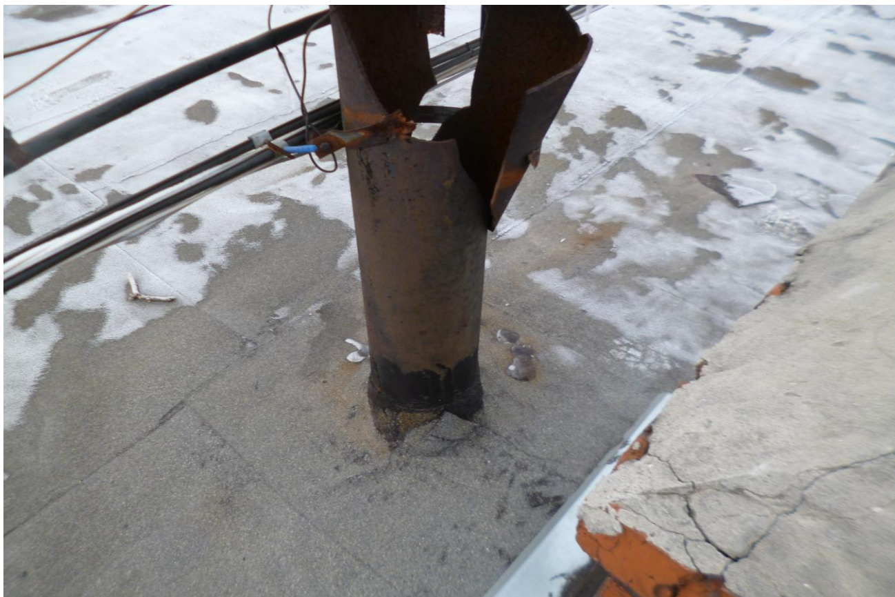
Фото 6. Разрушение фановых труб и примыкания кровельного ковра.
