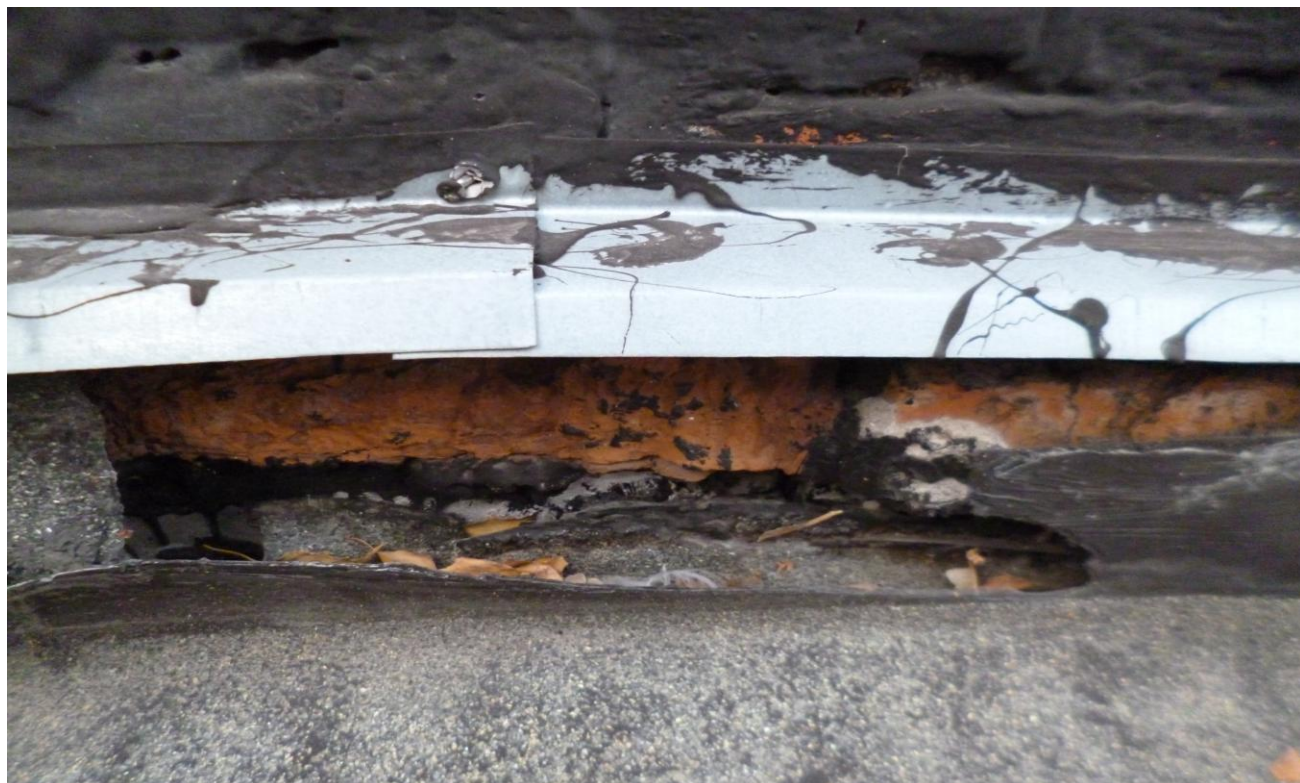
Фото 3. Вентканалы. Примыкание кровельного ковра.
